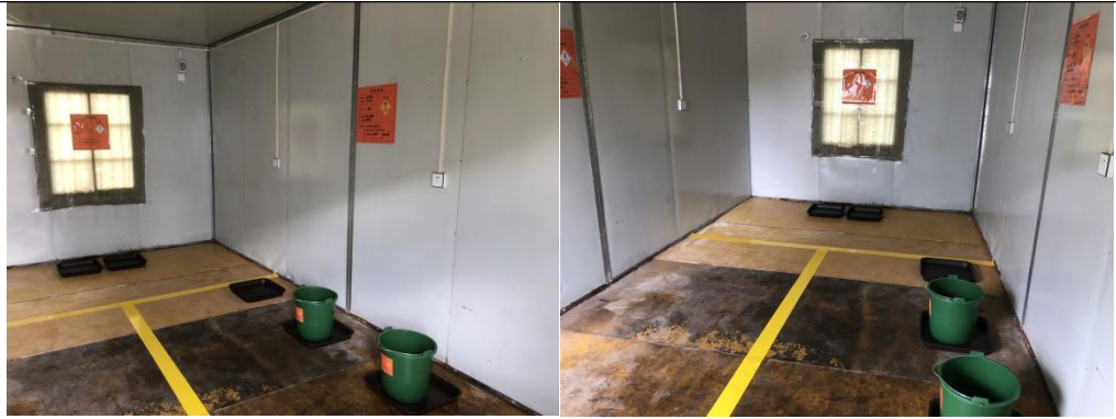
危废暂存间（内）
