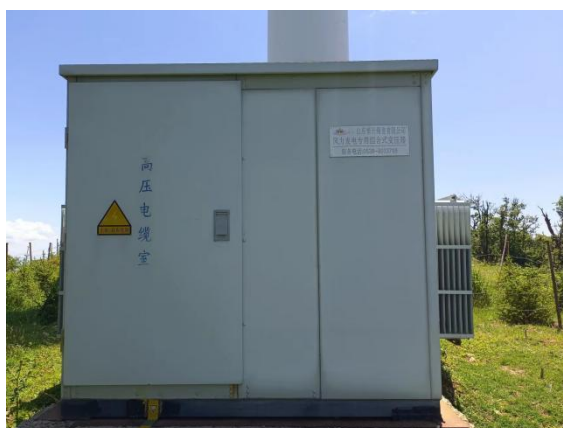
风机机位箱变处现状
